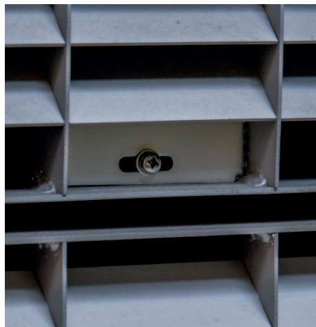
Elegant und kaum sichtbar: Die Verschraubung der Lamellenroste auf die Unterkonstruktion. Le vissage des caillebotis à lamelles à la structure porteuse est à la fois élégant et discret.
