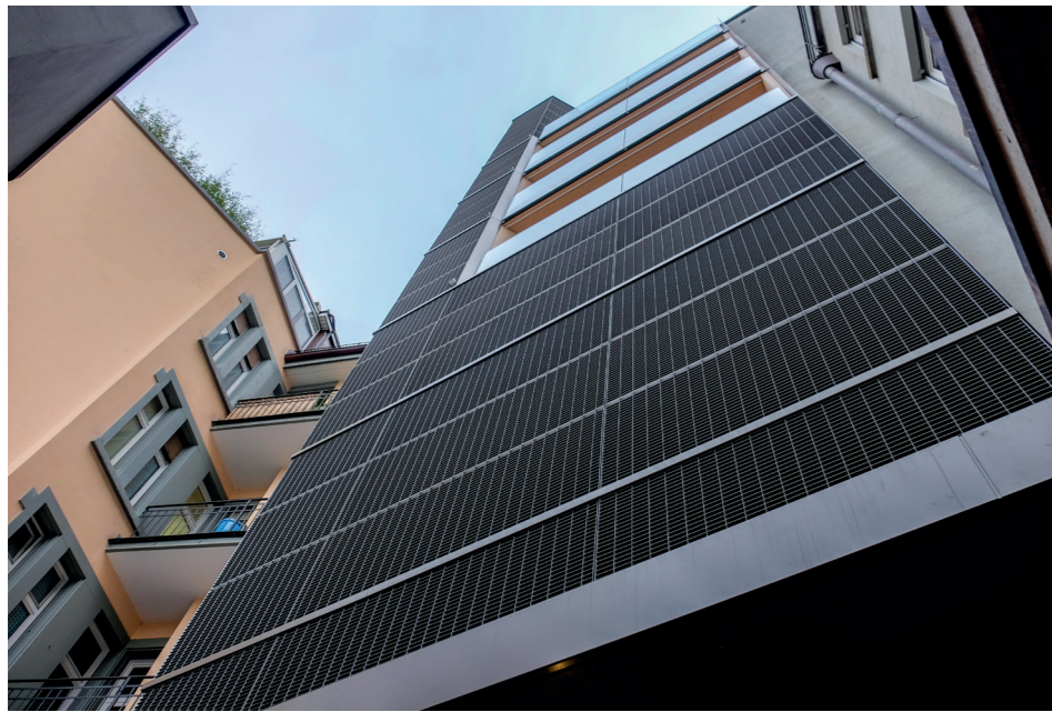
Ein gelungener Mix: Alter Bestand und moderne Konstruktionen treffen aufeinander. Un mélange réussi : l'ancien et le nouveau se rencontrent.
